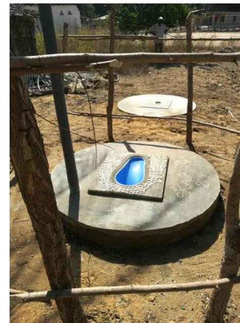
Figure 2: Latrine Ventilée (LV) pour zones à nappe affleurante avec fosse directe étanche, aérée et dispositif SaTo pan reliée à un décanteur et un lit d'infiltration
