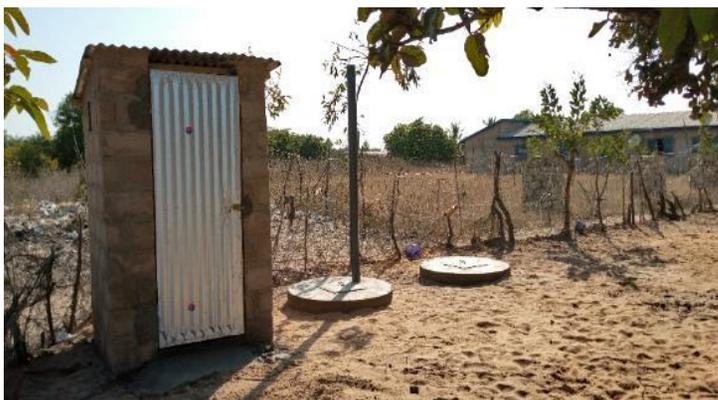
Figure 1: Toilette à Chasse Manuelle (TCM) pour zones à nappe affleurante : possède une cabine reliée à une fosse étanche avec décanteur et lit d'infiltration
