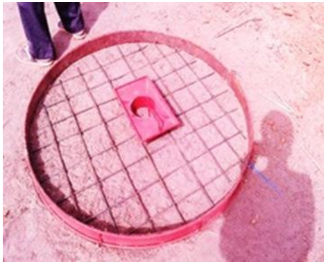
Ferrailage dalle normale
