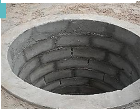
Fosse à briques
