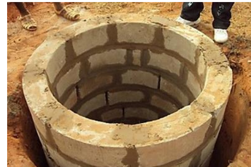
Fosse à briques
