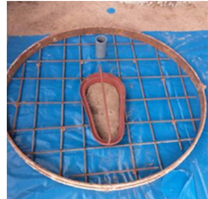
Ferrailage dalle avec Sato
