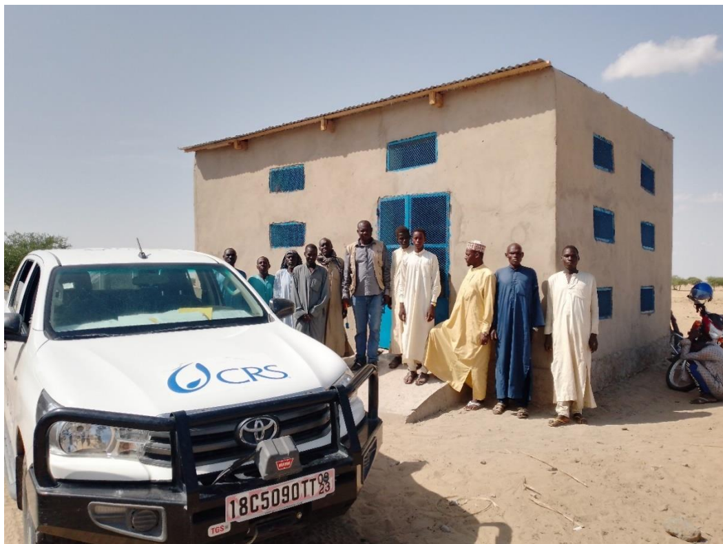
Un magasin communautaire de stockage d'oignon à Bouroumbia réalisé par l'approche Cash-for-Work. Photo par Allarasse Bienvenu/CRS
