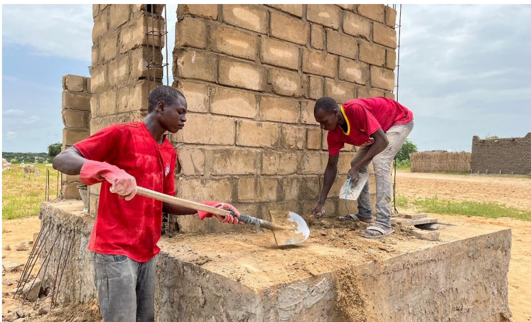
La construction de quatre nouvelles latrines dans la nouvelle école primaire du village de Moundaye, à Bol, dans l'ouest du Tchad, construite dans le cadre de l'"Appui à l'amélioration de l'éducation dans le bassin du lac Tchad" du CRS. Photo par Jennifer Lazuta/CRS.
