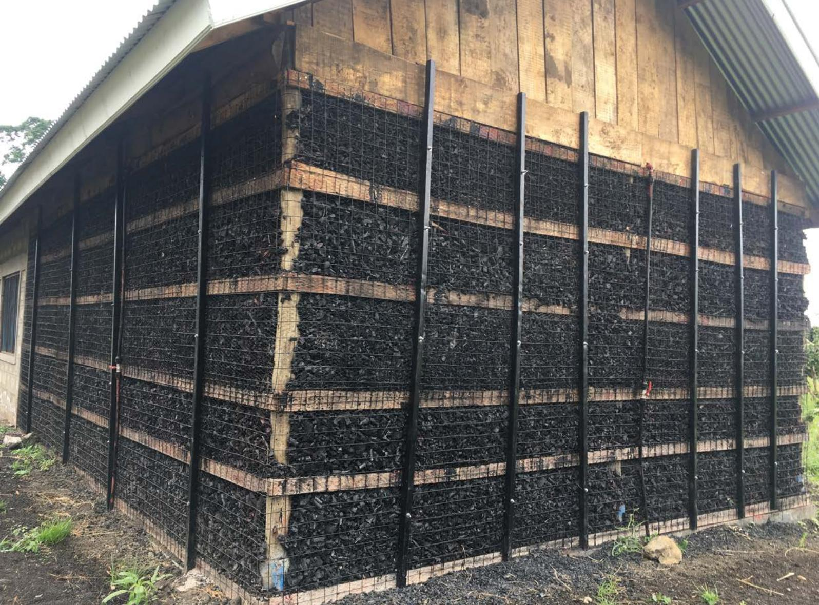
Installation de stockage à froid en Tanzanie grâce aux panneaux revêtus de charbon de bois. La technologie appropriée produit les conditions du stockage à froid sans utiliser de combustibles fossiles.
