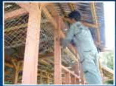
Pasang kawat dan bengkokan paku sepanjang bentangan untuk meregangkannya dengan kuat
