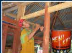
Sebelum memplester, pastikan mencat semua kayu dengan cat meni atau residu
