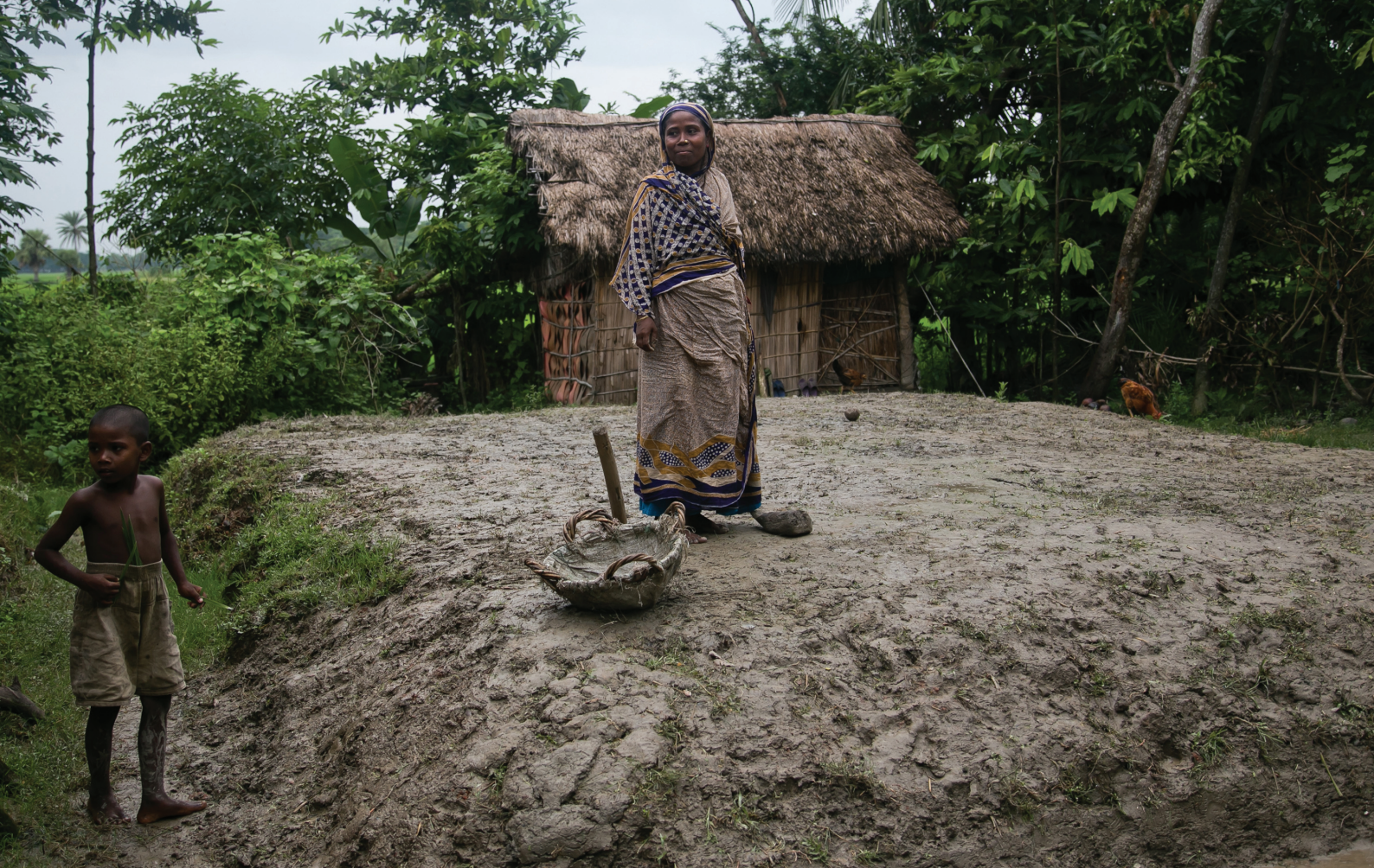
Rahima Begum construye la sobre cimentación de su futura vivienda al Sur de Bangladesh. Foto de Jennifer Hardy para CRS
