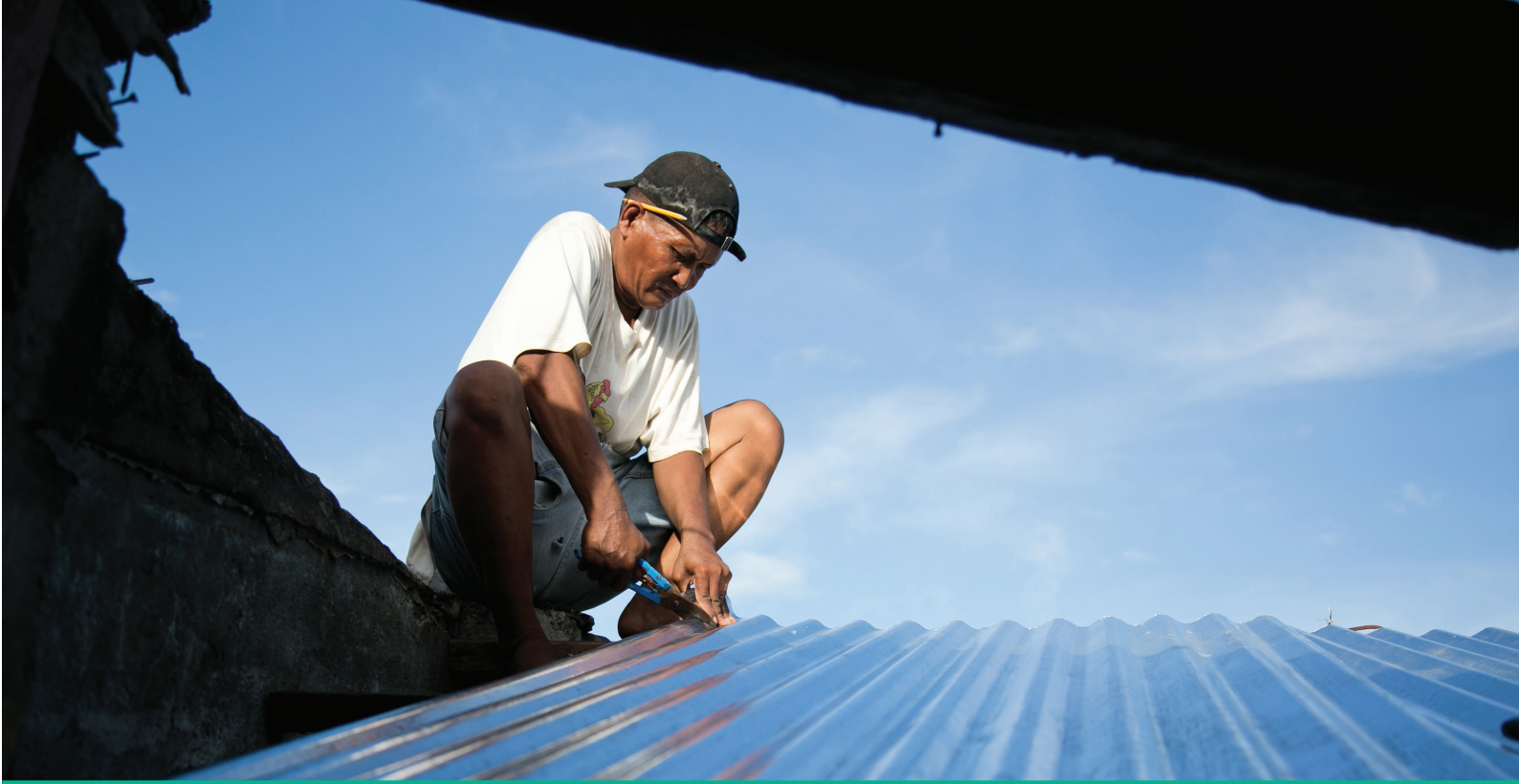
En las cinco localidades, la aplicación y el conocimiento público acerca de las normas de construcción y su aplicación fue muy baja. Foto de Jennifer Hardy para CRS
